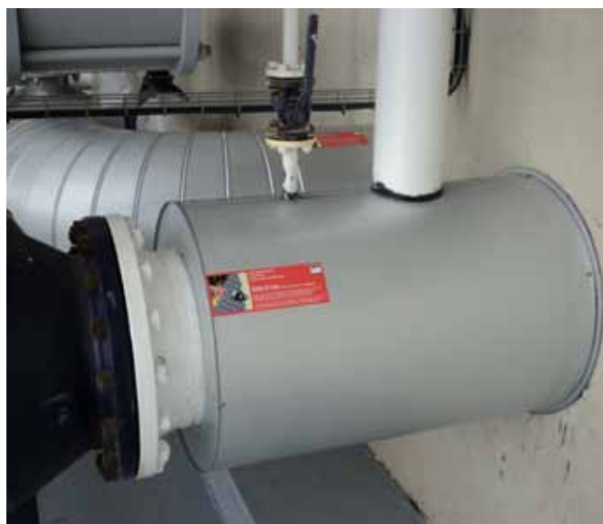
Tűzfalak csőáttörésének tűzvédelme
