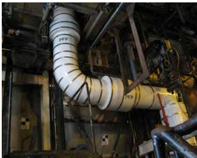
FOAMGLAS® XP: akár két óra motortűz ellenállás
