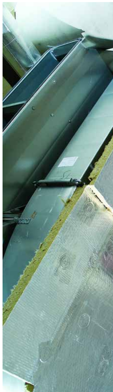
Két oldalról szigetelt, födémén átmenő csatorna nézete
