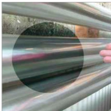
L'aspetto esteriore di un rivestimento Isolpak ALU® non viene danneggiato da bordatura e simili, come quelle necessarie per la costruzione di un rivestimento metallico
